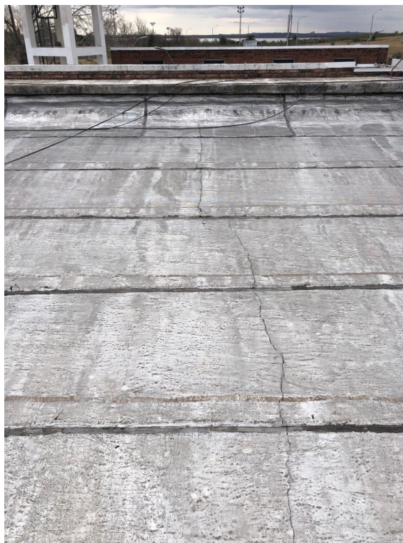
Fisuras por ausencia de junta de dilatación.
