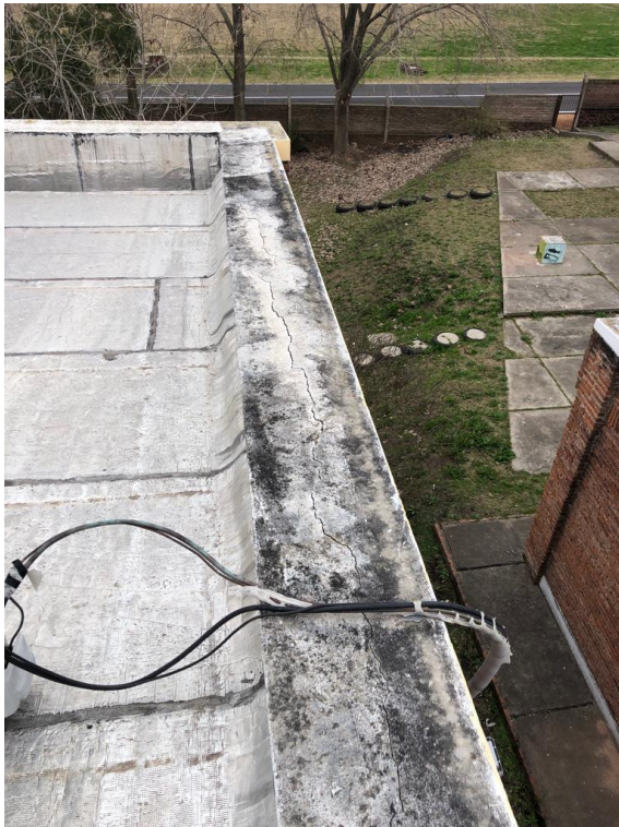
Fisuras a reparar sobre pretilas
