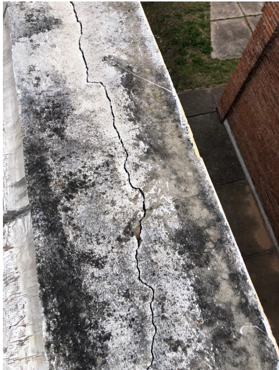
Fisuras a reparar sobre pretilas
