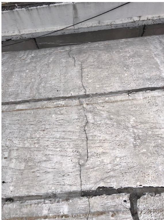
Fisuras por ausencia de junta de dilatación.
